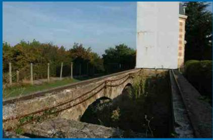
La lunette est protégée par un abri roulant sur des rails fixés sur un cheminement en pierre de 16 m de long.
