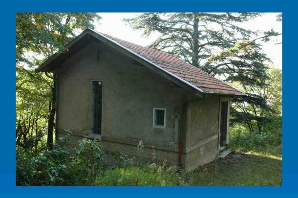
Ce pavillon, construit sans aucune pièce en fer, a abrité les principaux instruments de mesure du champ magnétique terrestre. Dès 1894, les mesures ont été perturbées, puis rendues impossibles, par le passage d'un tramway à proximité de l'observatoire!
